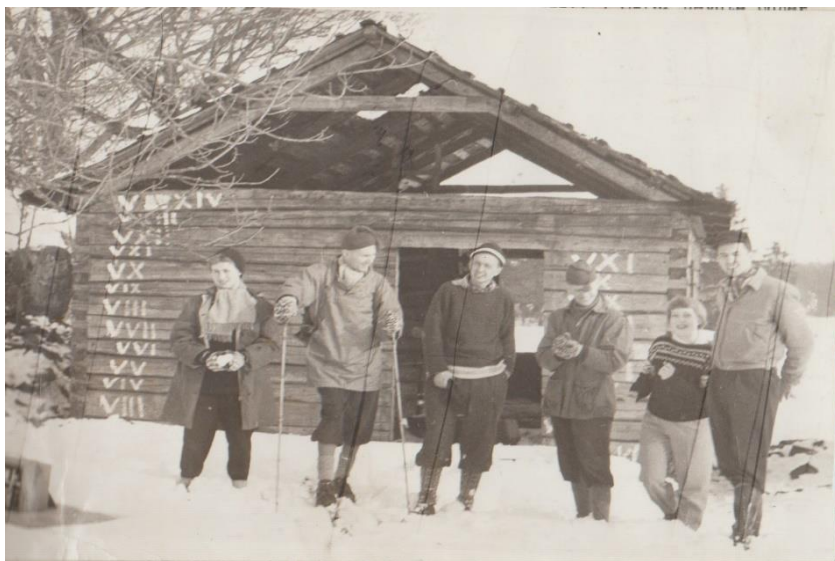
Under nedrivningen av «nye Canada» på Brønnerød i Våler, fra venstre Astrid Marthinsen, Håkon Westby, Fredrik Th. Bolin, Tor Anstensen, Anne Lise Pehrson og Per Anstensen
